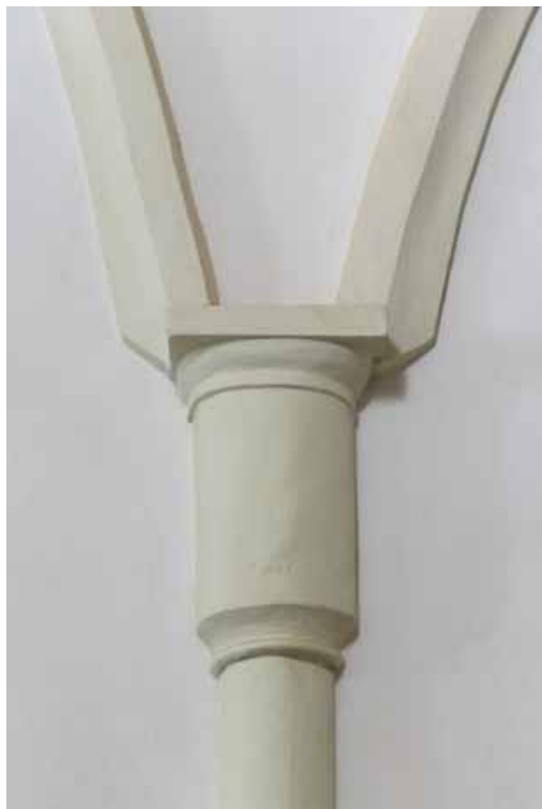
8. Boltindítás a hajóban
