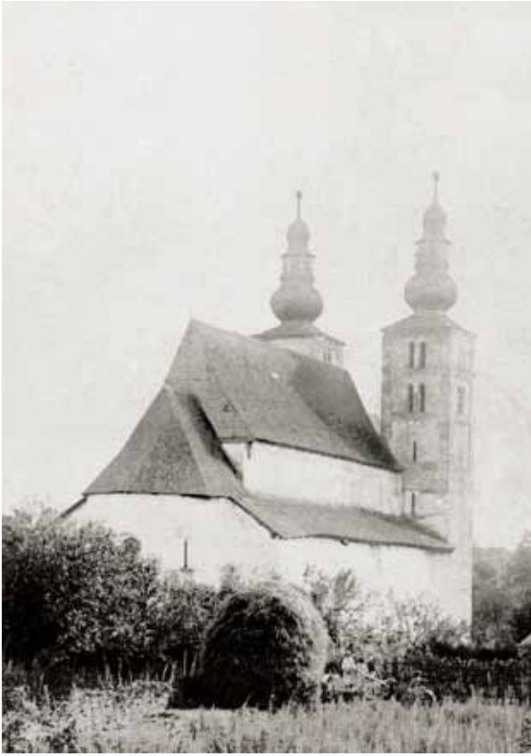
14. Ákos, a templom északkelet felől a restaurálás előtt
